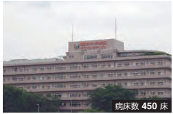
埼玉セントラル病院 病床数 450 床 〒354-0045 埼玉県入間郡三芳町上當2177 TEL:049-259-0161 http://www.ims.gr.jp/saitama_central/
